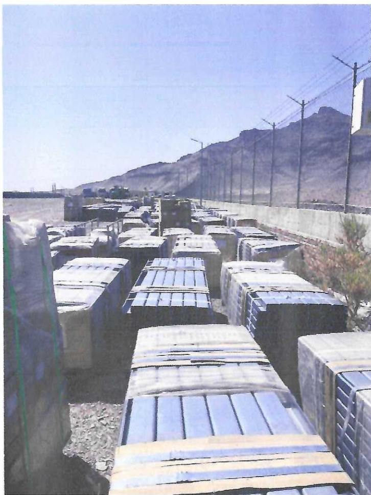
تصویر ۳ — بازرسی پالت‌های استراکچر در کنار سایر تجهیزات دیوشده
